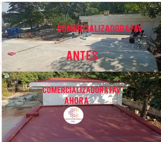
IMPERMEABILIZACIÓN PLANTA DE TRATAMIENTO DE AGUAS GAVIOTAS NORTE.
