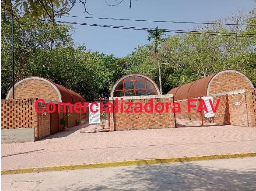
IMPERMEABILIZACIÓN DE LOS DOMOS DEL CENTRO DE CONVIVENCIA, CUNDUACÁN, TABASCO.
