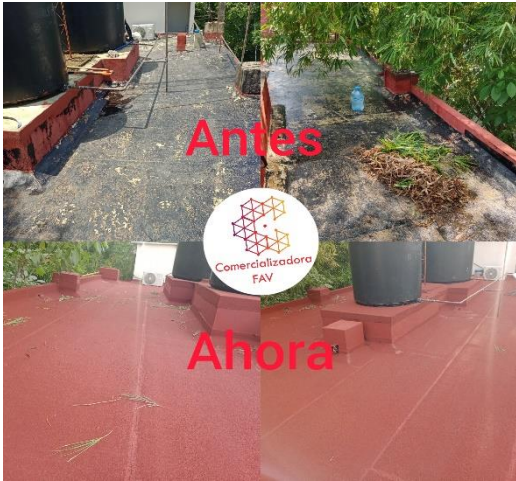
IMPERMEABILIZACIÓN QUINTA PALENQUE, CHIAPAS.
