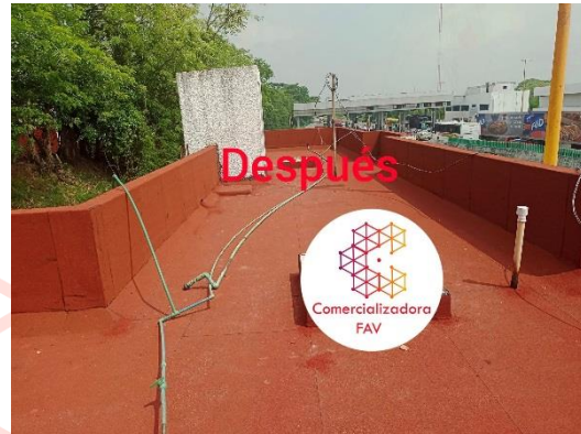
IMPERMEABILIZACIÓN DE LOS BAÑOS DE LA CASETA DE COBRO MACUSPANA/VILLAHERMOSA.
